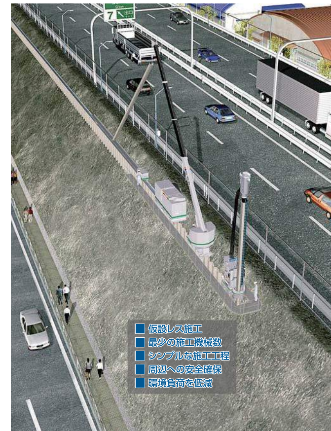
硬質地盤クリア工法の適用例
