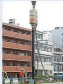
杭規格：H300×300 (L=28.5m) 発注：広島市 工事名：明治橋仮歩道橋設置工事
