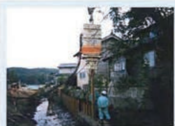
矢板規格：SP-Ⅱ型 (L=8m) 発注：石川県 工事名：大谷川広域基幹河川改修工事
