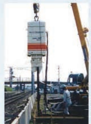
矢板規格：SP-Ⅱ型 (L=6m) 発注：JR九州 工事名：羽犬塚駅構内自由路新設他
