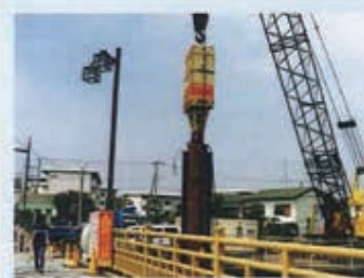
杭規格：φ600×12m 発注：神奈川県 工事名：総合治水対策特定河川工事(引地川)
