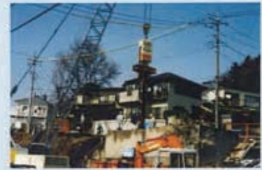
杭規格：φ500×15m 発注：東京都 工事名：道路改修工事及び補償代行事
