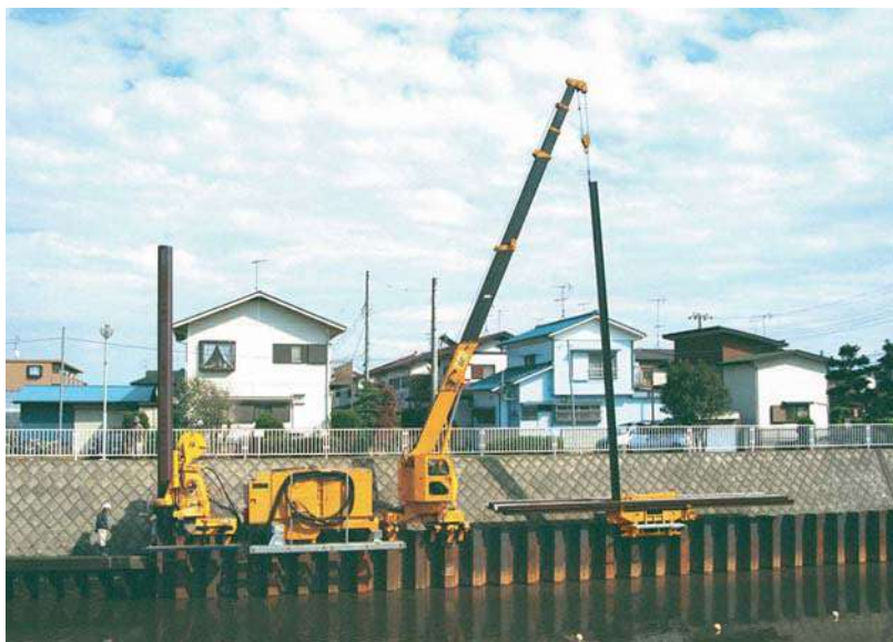
ノンステーピング工法による住宅地での治水対策工事
