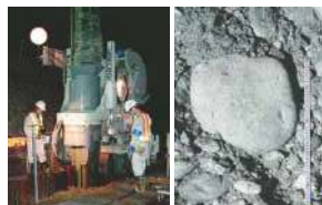
玉石混り層 (100 - 300mm) への圧入
