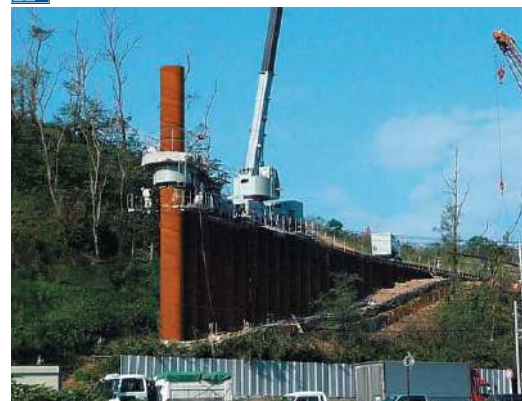
災害復旧橋脚補強 (北海道平取町沙流川平取橋)
