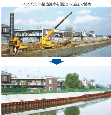
インプラント構造護岸を仮設レス施工で構築
