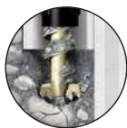
硬質地盤圧入
