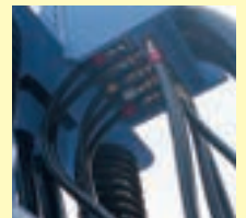
偏心モーメント制御配管部
