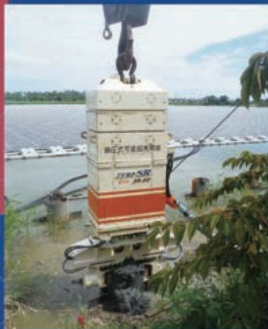
工事名: 岡山浦安水上メガソーラー発電所建設工事 杭規格: 鋼管杭Φ600(L=17.0m) 施工現場: 岡山県
