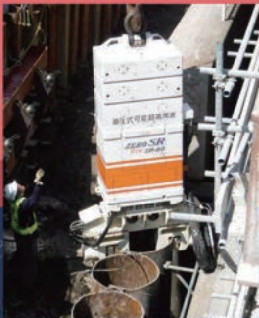
工事名: 横浜湘南道路引地川改良工事 (引抜き) 杭規格: 鋼矢板IV型(L=21.0m) 発注: 国土交通省
